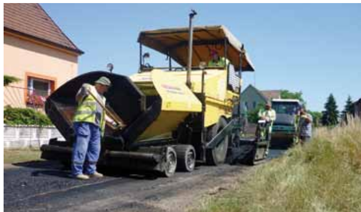
Pokládka nového povrchu v ulici Hasičská.
