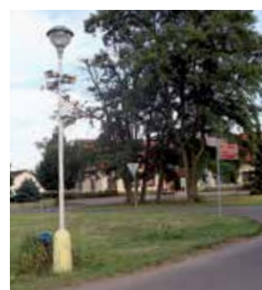
Nové nátěry sloupů jsou první etapou v rekonstrukci veřejného osvětlení.
