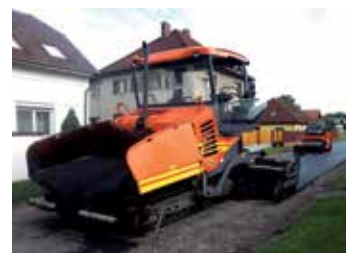
Celkovou rekonstrukcí prošla ulice Luční v Tišicích.
