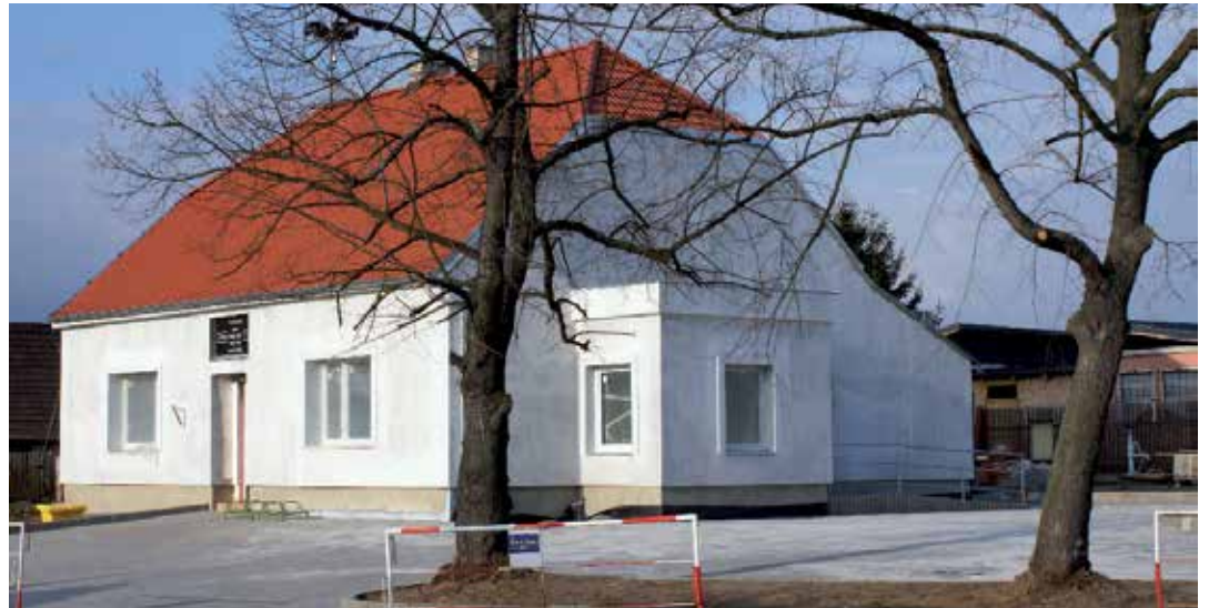
Rekonstrukce budovy pošty, parkovací a výjezdové plochy jde do svého finále.
