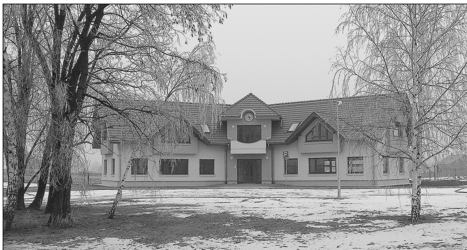
Budova nového obecního úřadu se po stavebním dokončení a úspěšné kolaudaci uložila k zimnímu spánku a čeká na jarní probuzení novým vybavením
