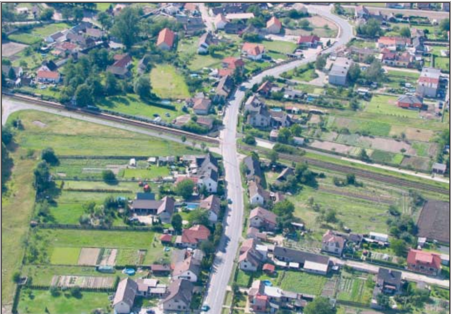
Pohled na železniční trať a ulice Mělnická/Boleslavská
