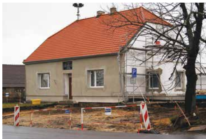
S rekonstrukcí budovy pošty bude současně vybudováno nové parkoviště.
