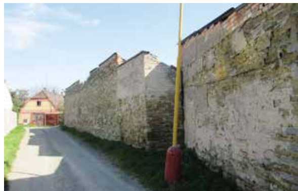
Dveře do prádelny, dnes zazděné, byly za sloupem veřejného osvětlení.
