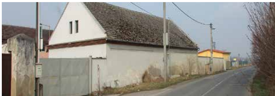
Současný pohled na bývalý objekt hostince „Kaberna“.
