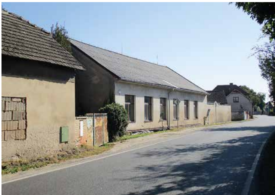
Objekt bývalého hostince U Literů, r. 2020.
